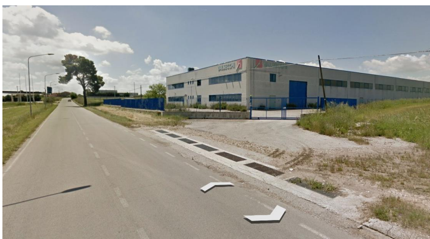
Figura 1: capannone industriale - , S. P. n. 44 - 71010 Chieuti FG (41.858110, 15.170867)
